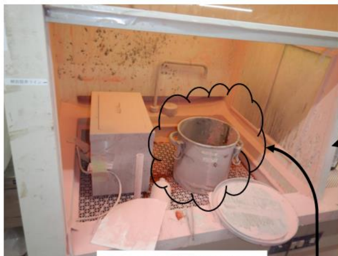
◎フード内写真（発火場所）
