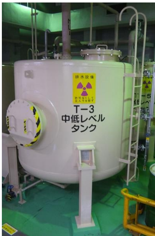
放射性廃液タンク
